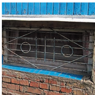
Так выглядят окна цокольного этажа
